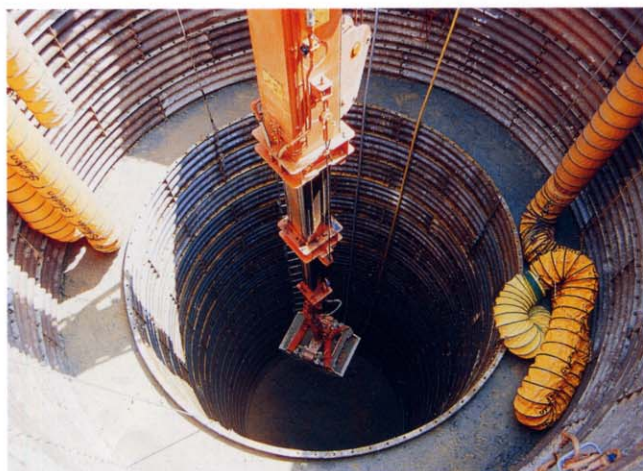
ロープテレスコ式クラムシェルによる鉄塔の基礎工事
